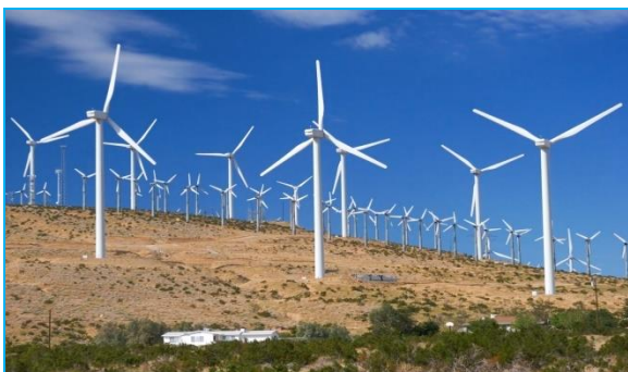
Shamol elektr stansiyasi
